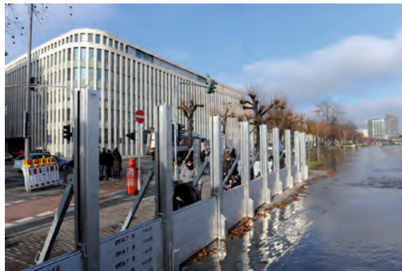
Rhein-Hochwasser vor dem Institut der deutschen Wirtschaft Köln (Foto: F. Lang)
